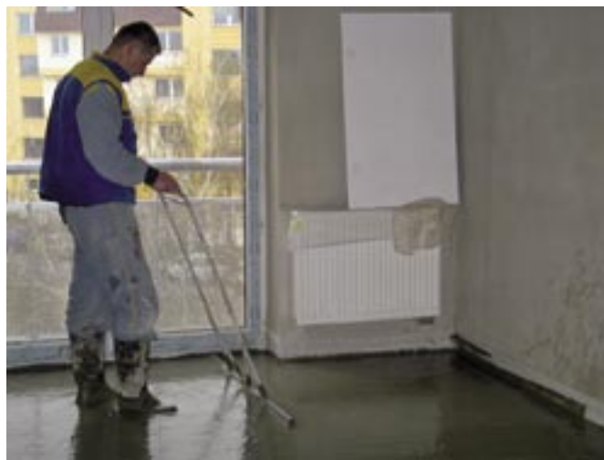
Úprava povrchu vyrovnávacej vrstvy
