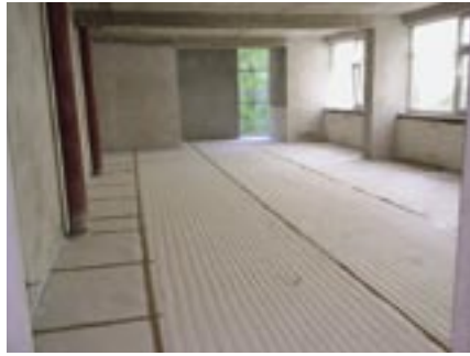
Položenie protihlukovej podložky na penobetón
