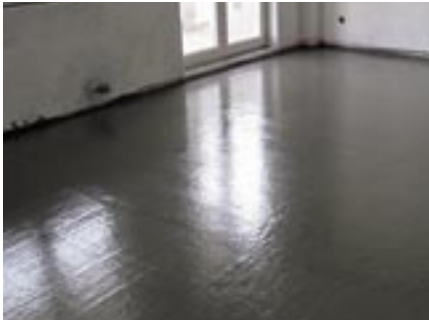
Správne vytvorená vyrovnávacia vrstva z penobetónu
