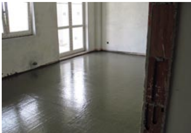
Príklady správne zhotovených podláh z penobetónu
