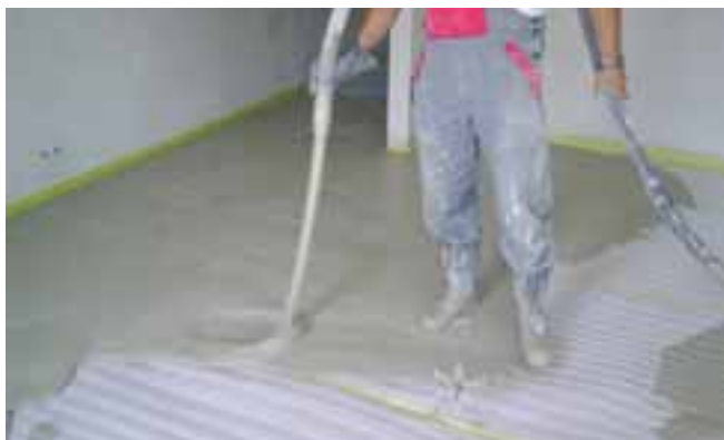
Aplikácia poteru na kročajovú izoláciu
