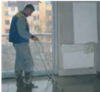
Úprava povrchu vyrovnávacej vrstvy penobetónu
